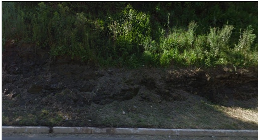
Figura 41 – Sequência de argilitos, siltitos e folhelhos da Formação Serra Alta, com extrema fissibilidade proporcionando efeitos de empastilhamento junto a rodovia BR-280 próximo ao rio Canoinhas.
