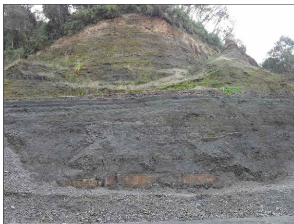
Figura 42 - Vista frontal de talude de corte em sequência de folhelhos e arenitos da Formação Teresina, na rodovia BR-101 entre Bom Retiro e Lages.
